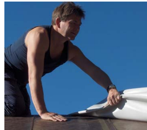
Projektleiter Res Schmid legt selbst Hand an. Er ist im Vorstand des SCE verantwortlich für die Infrastrukturen.
