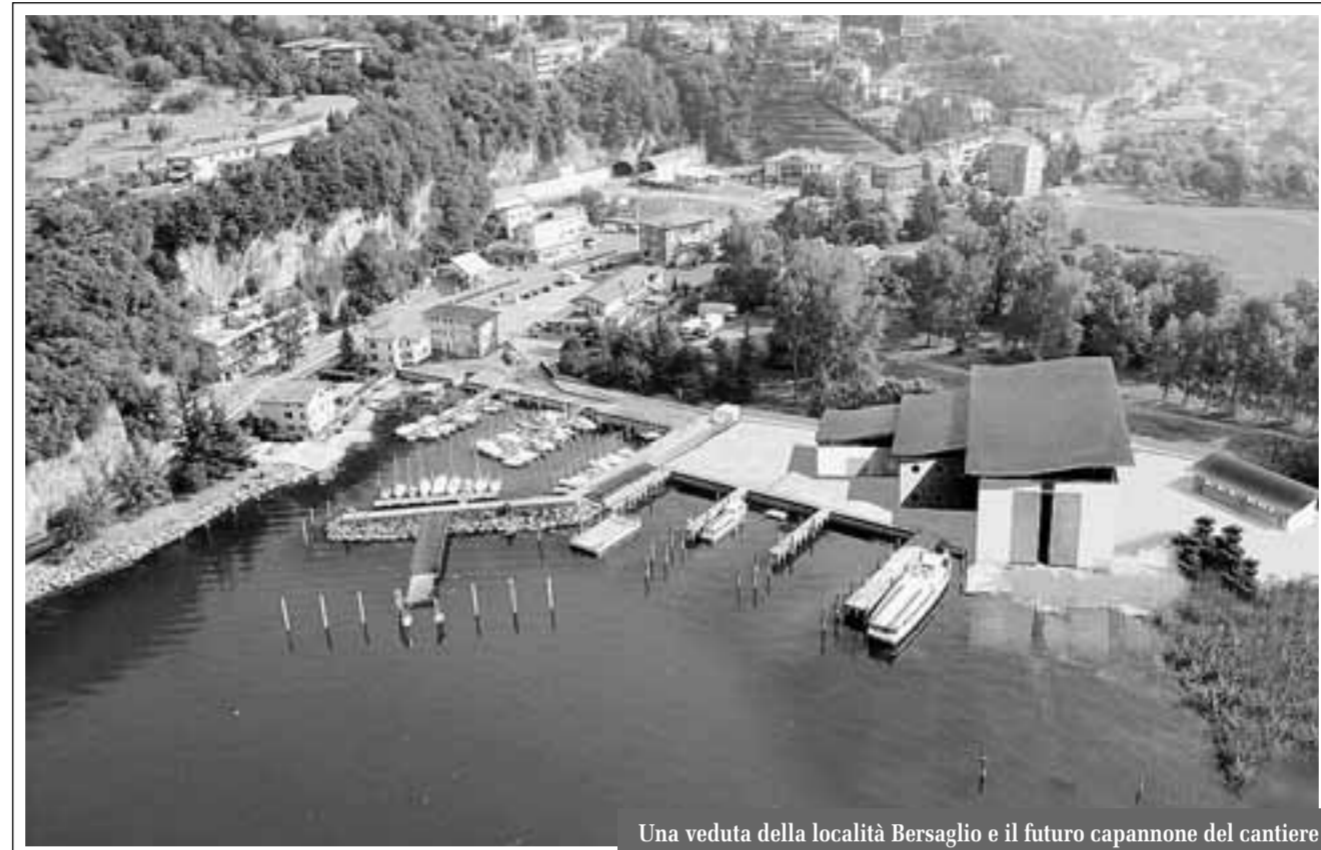
Una veduta della località Bersaglio e il futuro capannone del cantiere
