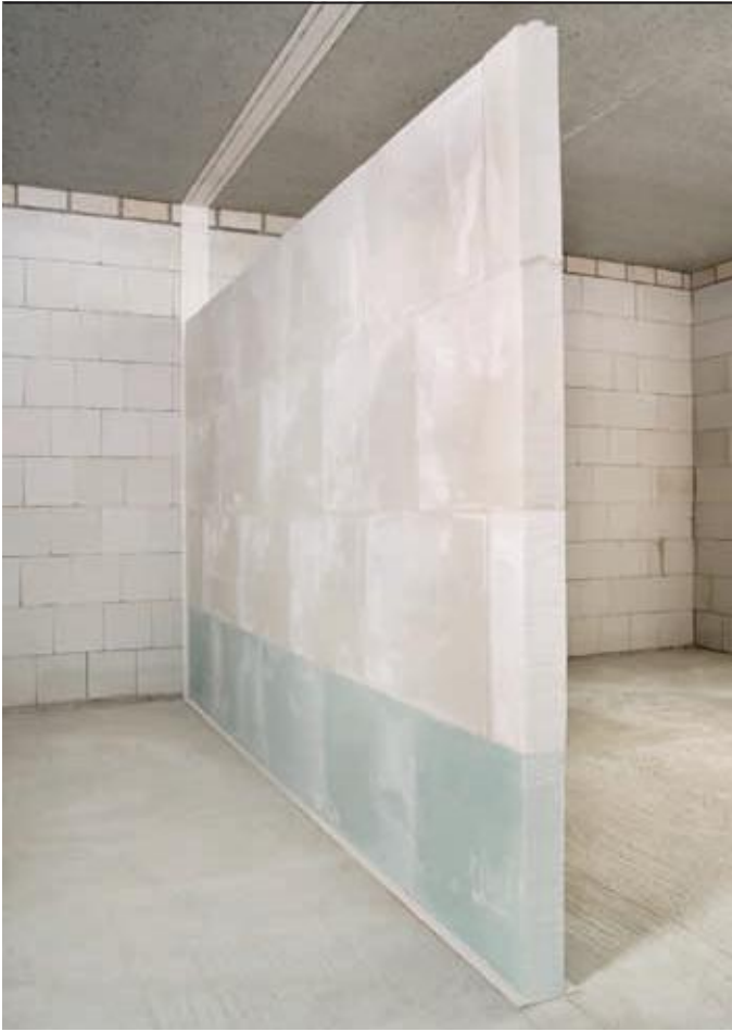
Der allseitig elastische Anschluss mit Randstreifen aus PE-Schwerschaum entkoppelt die Trennwände akustisch. Die untere Reihe wurde hier mit bläulich eingefärbten, hydrophobierten Platten ausgeführt.
