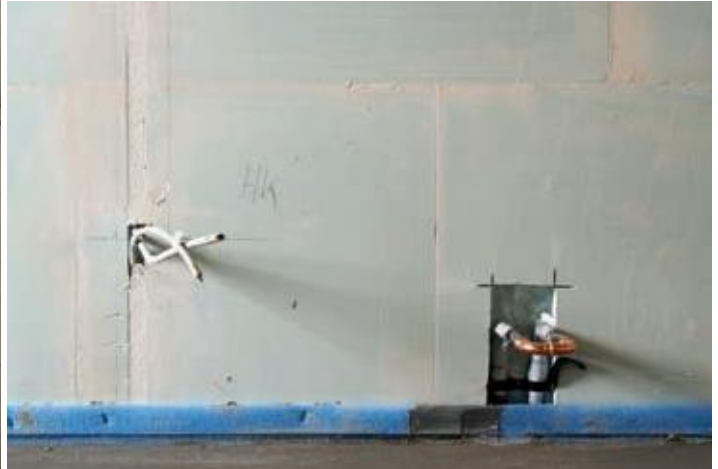
Die leichten Trennwände können ohne zusätzliche Wandträger oder Deckenverstärkungen frei im Grundriss angeordnet und bei Bedarf auch nachträglich ergänzt oder wieder entfernt werden. Öffnungen für Türen oder Installationen lassen sich an jeder Stelle sägen bzw. fräsen.
