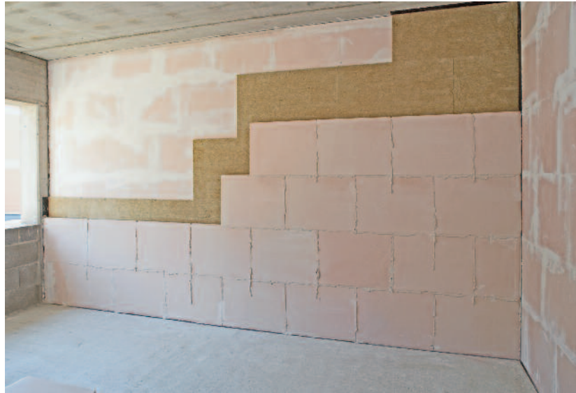
3 Schlanke und leichte Trennwände aus massiven Gips-Wandbauplatten ermöglichen einen flexiblen Innenausbau bei größtmöglicher Ausnutzung der Grundfläche. (Fotos: Multigips)
