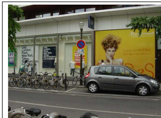
NON : Une place de stationnement supprimée (et non remplacée) pour y mettre des Vélib à Boulogne Billancourt (92100)
