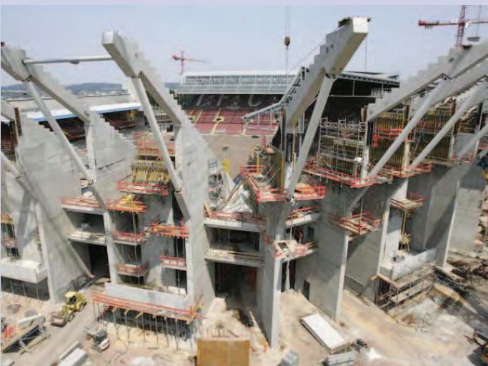
Mai 2005: Es geht voran mit dem Umbau des Stadions.
