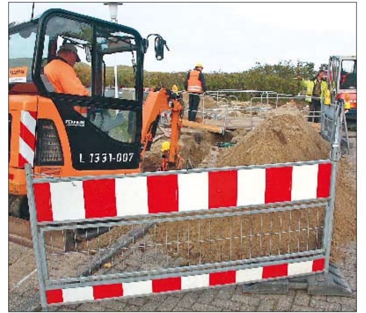
Im Gewerbegebiet auf Norderney werden zurzeit die Gas- und Wasserleitungen erneuert. Nach Angaben eines Mitarbeiters der Wirtschaftsbetriebe Norderney wurden diese ungefähr 1970 verlegt und sind nun verrostet.
