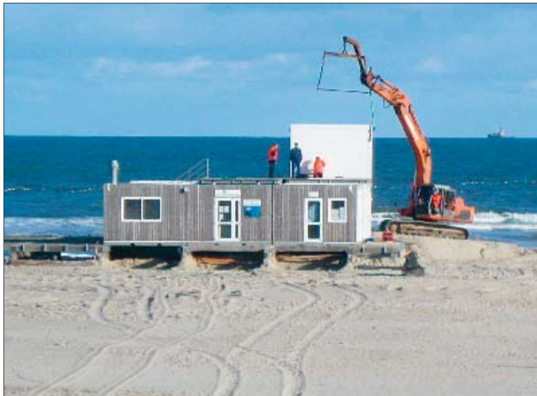
Die Strandsauna wird von ihrem Sockel gehoben.
