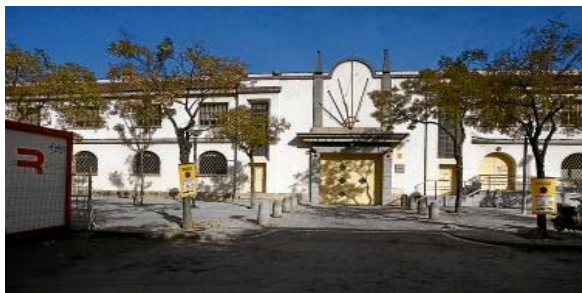
Fachada exterior de la cárcel de la Trinitat, cuyo futuro están debatiendo la administración y los ciudadanos. Foto: SERGIO LAINZ
