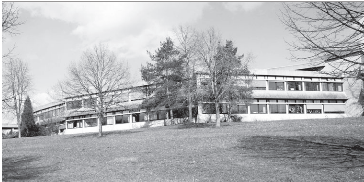
Soll neue Fenster, Fluchttüren und eine Dachsanierung aus dem Konjunkturprogramm II erhalten: Das Hohbergsschulzentrum. Bild: Pavlović
